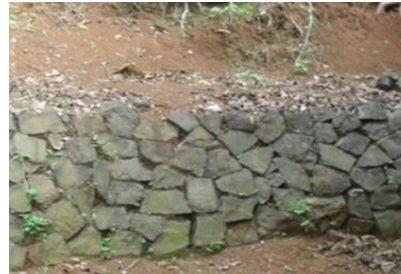
Gambar 2. Pembuatan Talut dengan batu dan tidak di Semen
