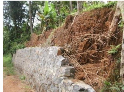
Gambar 1. Foto Pembuatan Talut dengan Batu dan di Semen
