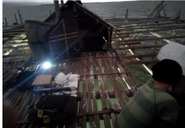
Gambar 6. Proses pemasangan alat
