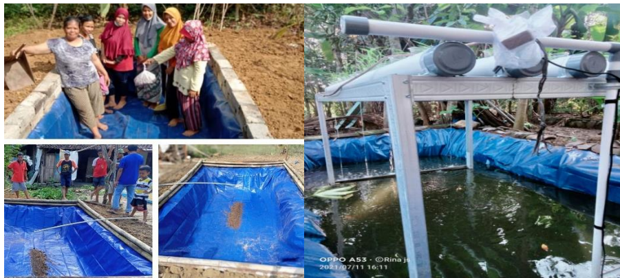
Gambar 3 . Pembuatan rangkaian subsistem akuakultur (kolam budidaya ikan)
