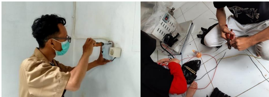
Gambar 3. Pengerjaan instalasi listrik
