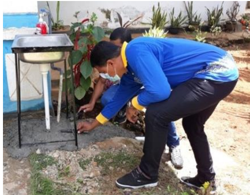
Gambar 5. Pemasangan tempat cuci tangan
