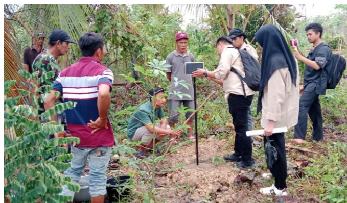
Gambar 8. Instalasi set alat sensor kebakaran di lapangan
