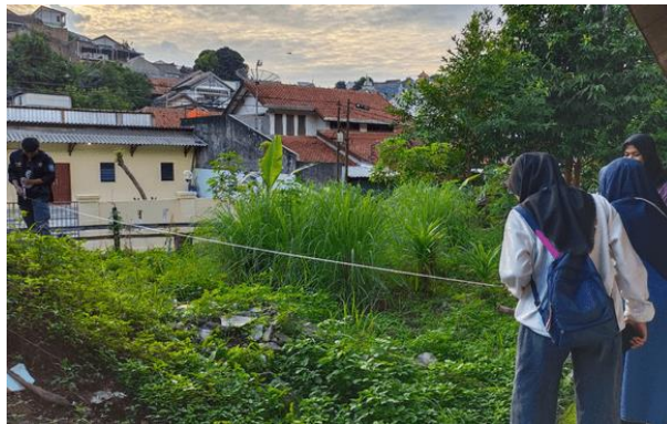
Gambar 3. Pengukuran lahan kolam dan survei lokasi kondisi eksisting
